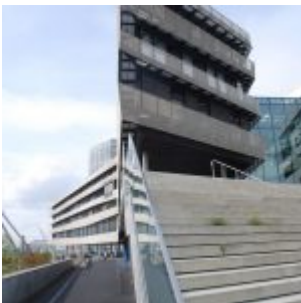
Budova HafenCity Universität Hamburg
