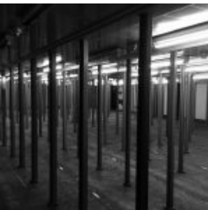
Sklepní prostory v NLI, které by v budoucnu měly sloužit jako prostor pro čtenáře
